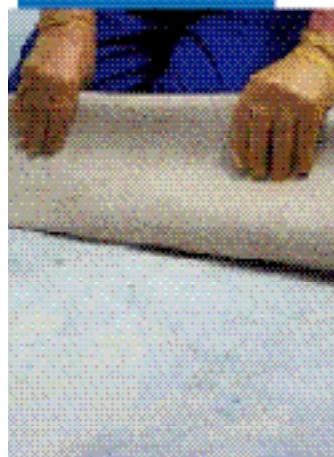
Mapetack-kel ragasztott szőnyegpadló eltávolítása
