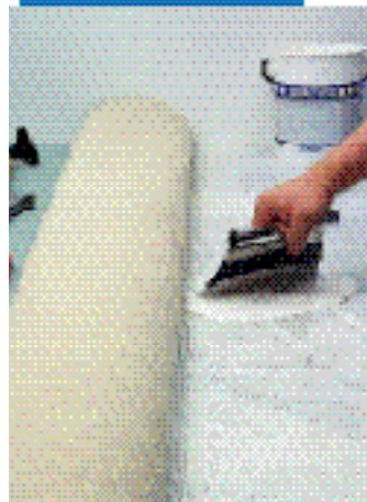
Szőnyegpadló fektetése Mapetack-kel
