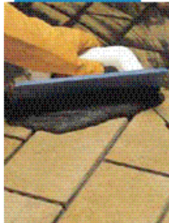
Küttéri klinker padlóburkolat fugázása Fugolastic-kal kevert Keracolor GG-vel
