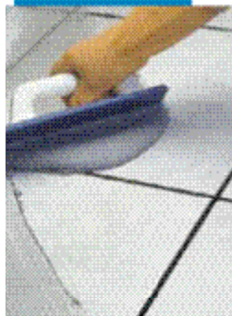
Kerámia padlóburkoló lapok fugázása fugázógumival
