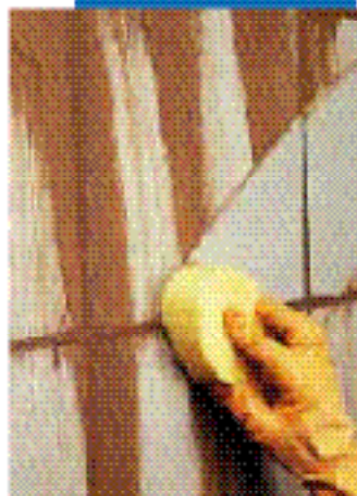
Falburkolat tisztítása tisztítószivaccsal
