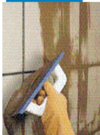
Kültéri falburkolat fugázása fugázógumival
