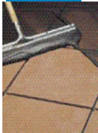
Terrakotta padlóburkoló lapok fugázása gumilehűzővel
